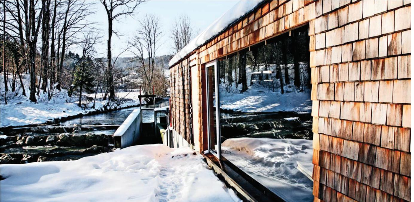
Die statisch tragende Holzriegelfassade ist innen mit grob strukturierten raumhohen OSB-Platten beplankt und hat außenliegende Lärchenschindeln. Die Fassade konnte übrigens in Elementbauweise vorgefertigt werden und dadurch zur Reduktion der Bauzeit beitragen. Insgesamt kann oh456 auf einen interessanten, sowohl ästhetisch als auch nutzoptimiert ausgeklügelten Mix an Materialien verweisen.
